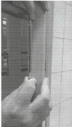
1 A medição foi iniciada da esquerda e seguiu para direita, sempre marcando a posição de sua base para dar sequência a próxima medida. ✓
